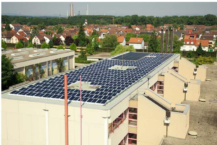
und damit besser für unser Dach geeignet, allerdings ist auch der Ertrag ein wenig geringer. Die Anlage hat eine Größe von 133,7 m<sup>2</sup> und eine Leistung von 10,676 kWpeak. Sie ist Eigentum der Stadtwerke Karlsruhe, allerdings erhält das Schulzentrum den prozentualen Anteil von 3 kWpeak quasi als „Dividende“ geschenkt. Bis 2013 wurde
